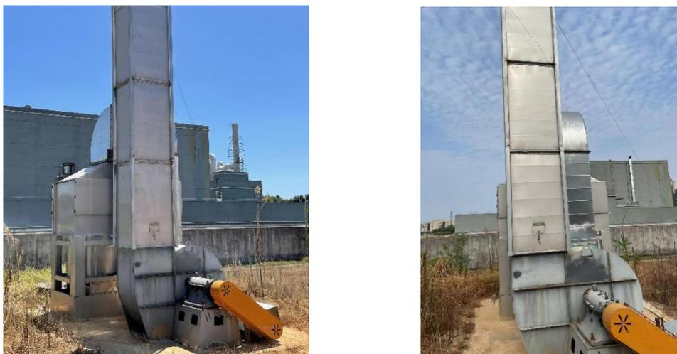
图 3.1.4-1 生物反应车间排气筒废气采样口设置情况
